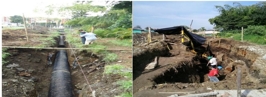
Imagen 14. Construcción interceptor Santa Isabel
