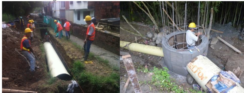
Imagen 10. Construcción interceptor La Víbora
