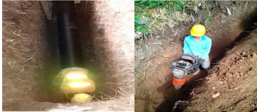
Imagen 15. Construcción interceptor Manzales
