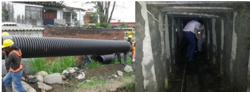
Imagen 12. Construcción interceptor Cañaveral
