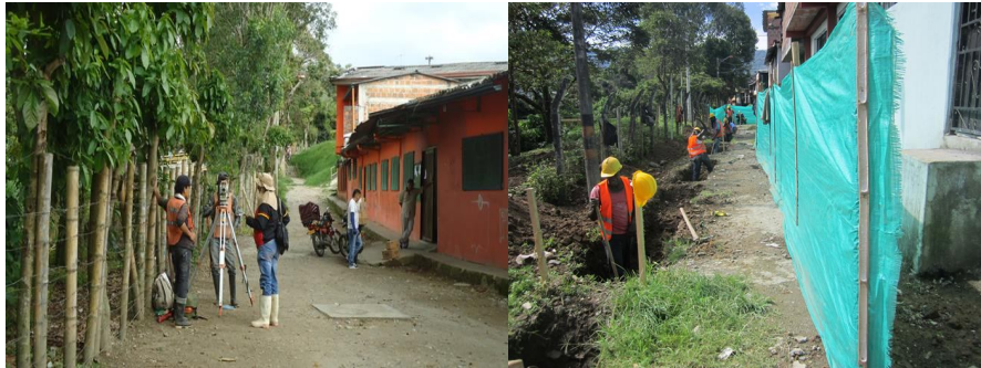
Imagen 13. Trazado y excavación interceptor Molinos
